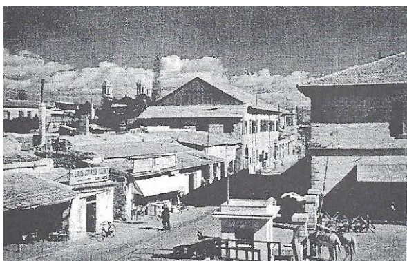
Ο παραλιακός δρόμος όπου διακρίνεται το Κονάκι
