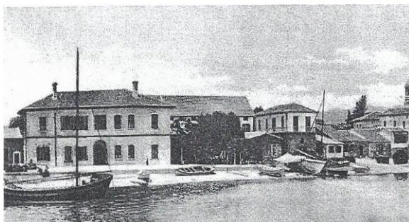
Το διώροφο κτίριο στα αριστερά που λειτούργησε σαν το δεύτερο δικαστήριο, κτηματολόγιο, διοικητήριο, ταχυδρομείο και κτηματολόγιο.
