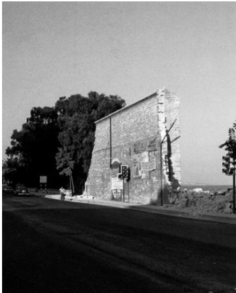
Κατεδάφιση Εναερίου, Λεμεσός
